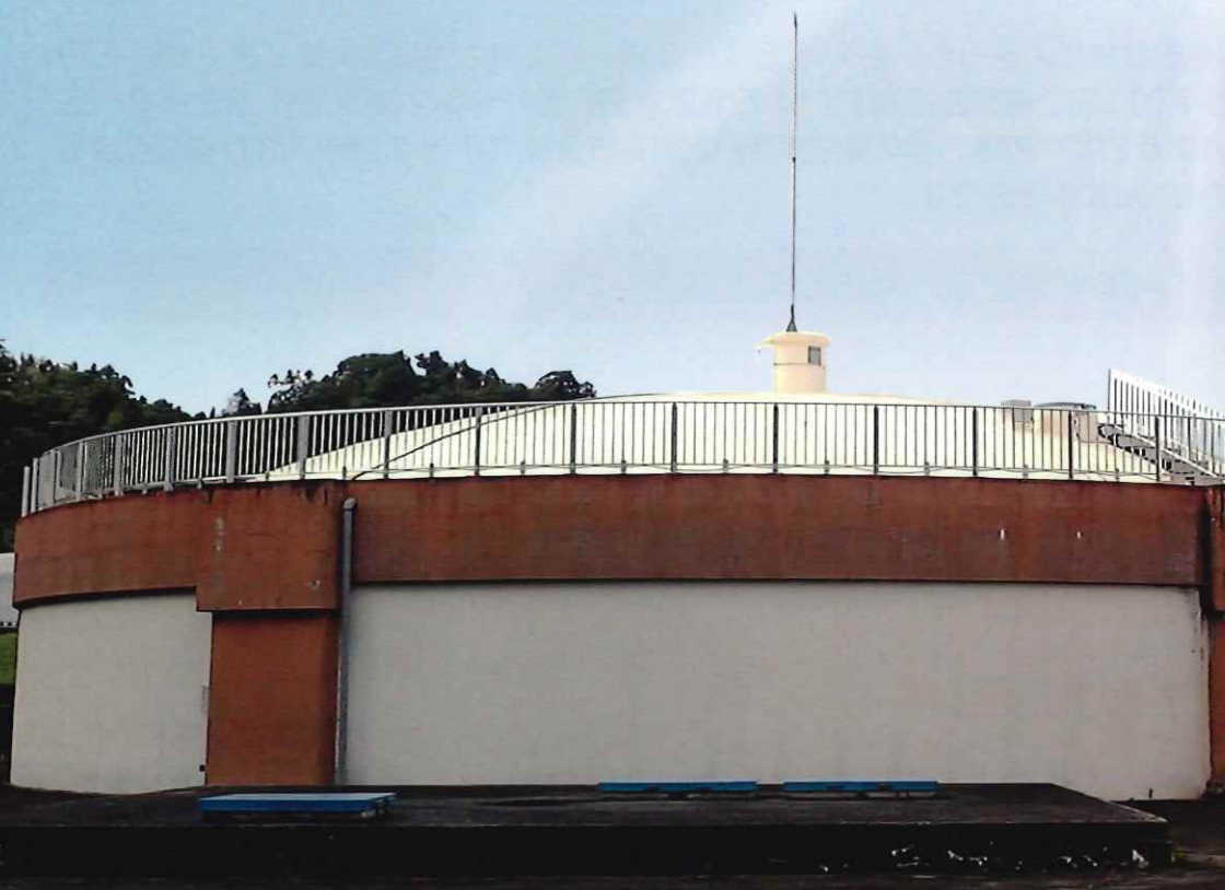
◆写真…中山町 土橋配水池
