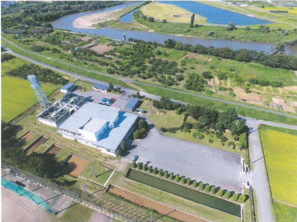
企業団事務所及び浄水場（空撮）
